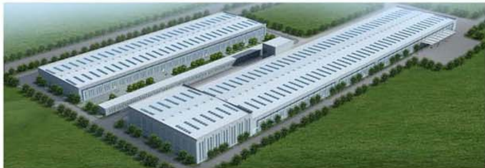
山东南山铝业股份有限公司轨道交通项目
